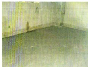
d、干拌砂浆或细石混凝土填充
