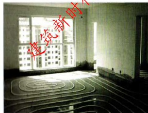
c、铺设热水管道或加热电缆
