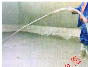
a、浇注HT泡沫混凝土
